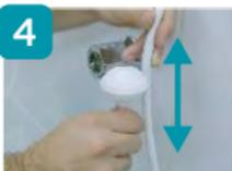
Encaixe a Baby Ducha na mangueirinha, ajustando-o de acordo com a altura da criança. Ligue o registro de água para testar a instalação hidráulica. Certifique-se que não há vazamentos. Depois desligue o registro novamente.
